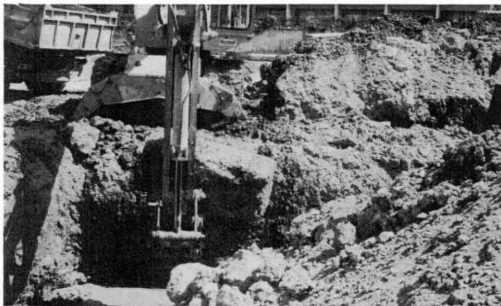
Lavori di fondazione presso la chiesa di S. Maria della Vittoria (1975) hanno rivelato l'esistenza di antiche attrezzature portuali. Qui un masso di molo.
