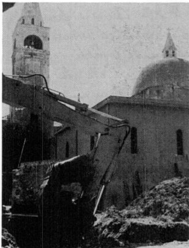
Il retro della chiesa di S. Maria nel 1975 durante i lavori che dovrebbero aprire la chiesa anche dalla parte nuova della città. Nella pagina accanto una cartolina turistica della facciata.
